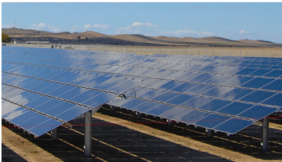
Rysunek 8.16 Instalacje ogniw fotowoltaicznych w skali przemysłowej są budowane w rejonach świata o dużym nasłonecznieniu po to, by wytwarzać energię elektryczną. (Źródło: Sarah Swenty)
